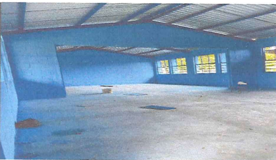
Foto 5: pintura de paredes finalizada
