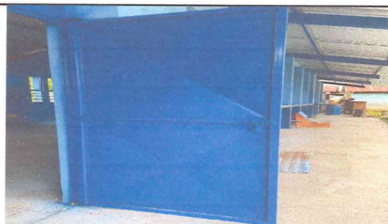
Foto 4: colocacion de puertas finalizada
