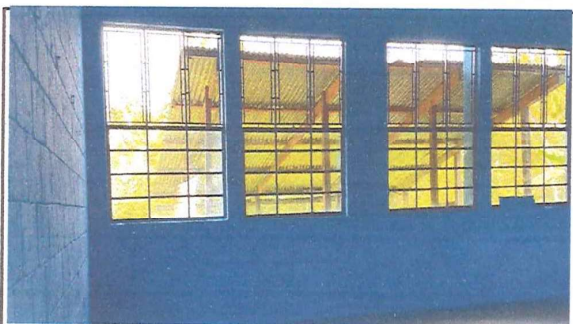
Foto 3: pintura en ventanas finalizada
